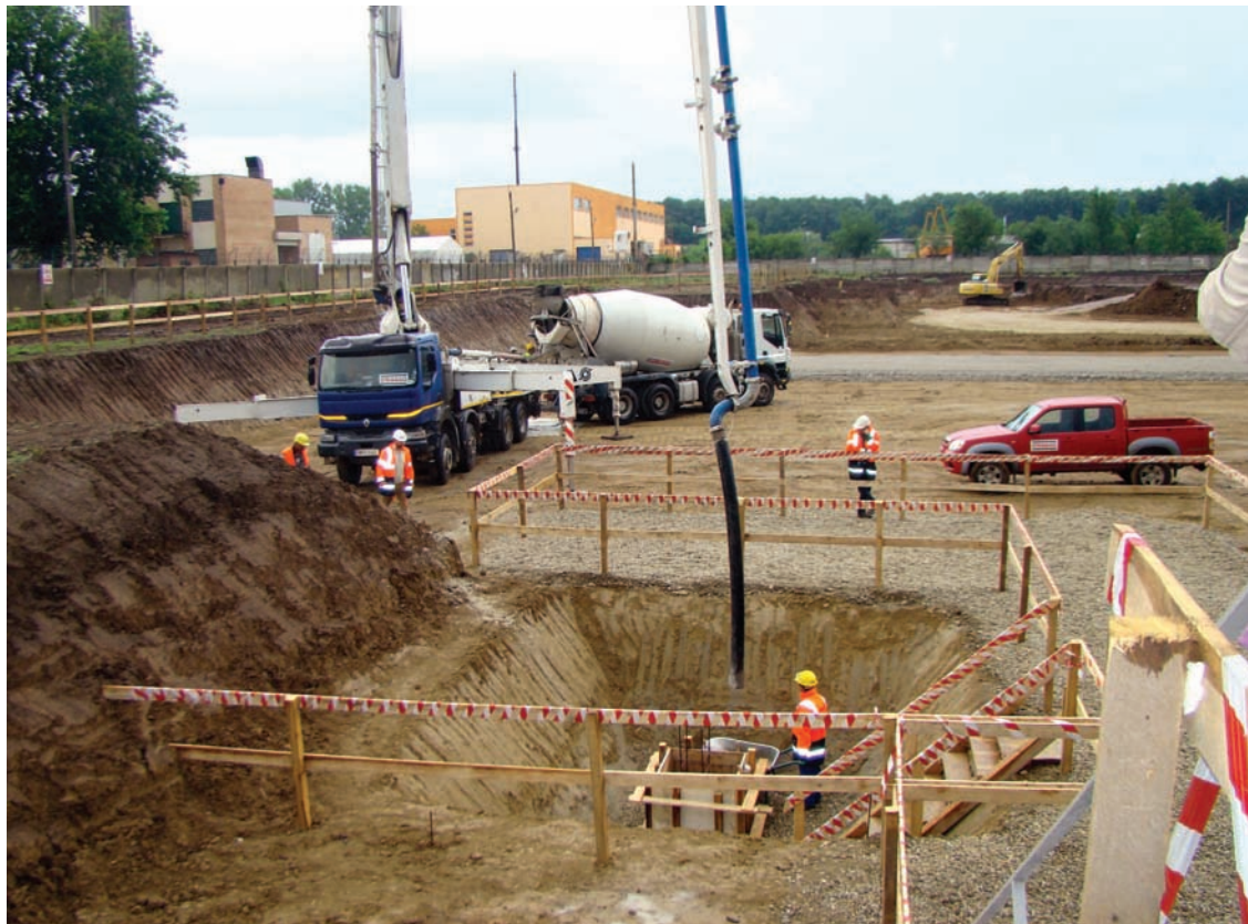
Șantier ELI - finele lunii iunie 2013
