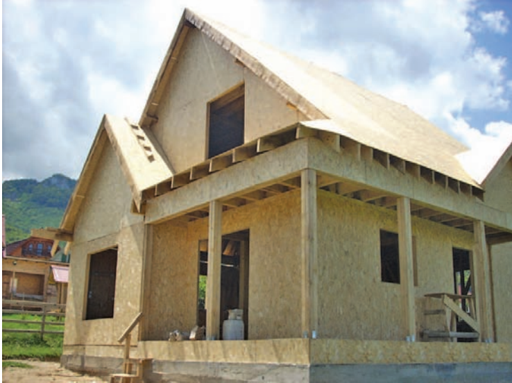
Casă din lemn construită în localitatea Predeluț. Firma producătoare este Eco Traditional Construct ( www.caselemn.orice.net )
